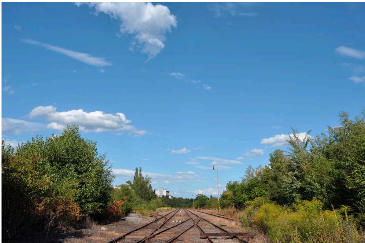
Obr. 1 Pohled na zájmové území směrem od ul. Želivského.
